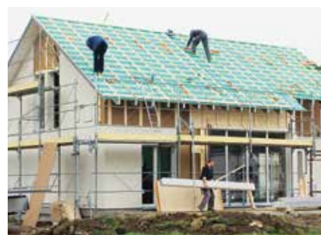
Fertiger Rohbau nach nur einem Tag Montagezeit.
