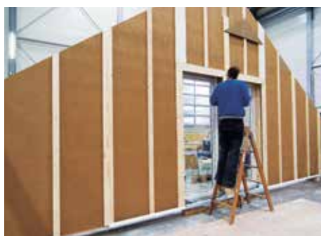
Fertigung der Einzelteile in der Produktionshalle.
