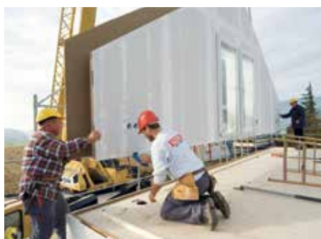
Montage der vorgefertigten Teile auf der Baustelle.
