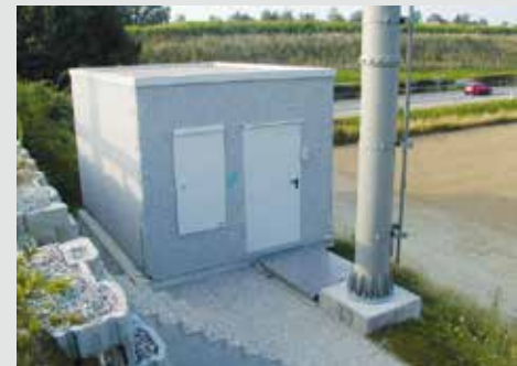
Technikkabine mit Flachdach und Inkalitfassade. Die Aussenhülle erweckt den Eindruck einer Betonkabine.
