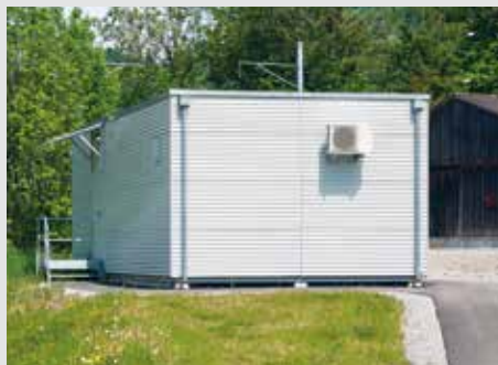
Grossraumkabine mit Flachdach und Alufassade.
