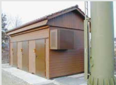
3er-Technikkabine für unterschiedliche, unabhängige Nutzer am gleichen Standort. Mit Giebeldach und Châlet-schalung.
